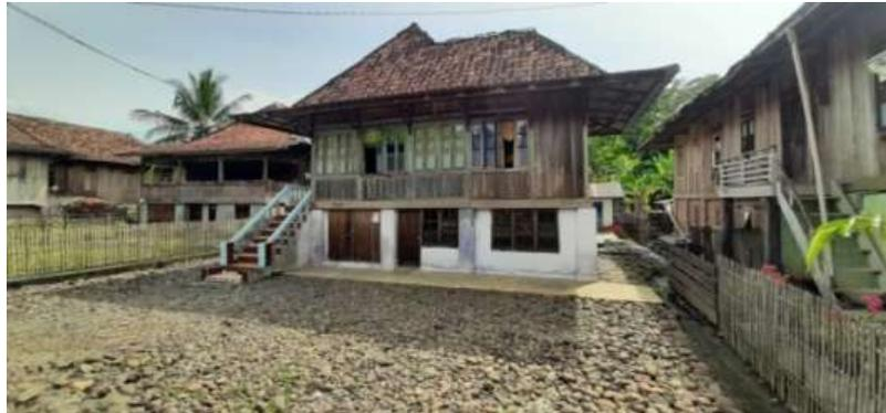
Gambar 3 : Rumah Limas Panggung Menggunakan Beton
